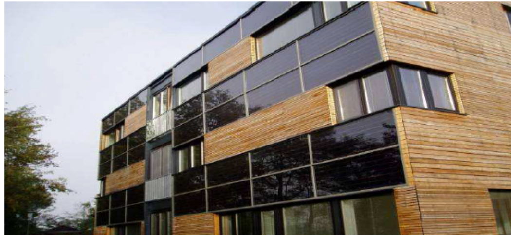
Formschöne Fassadenintegration von solarthermischen Kollektoren bei der Wohnanlage Aussichtstraße in Villach.
